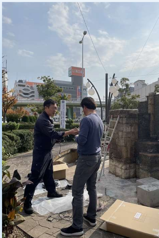
クラブ会員がスキルを活かして工事等の設営を行う。
