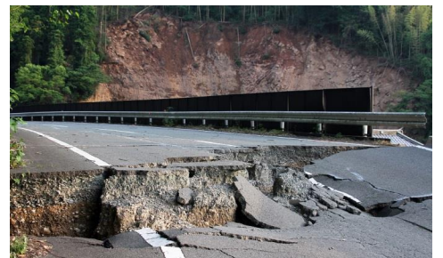
道路断裂・土砂崩れ
