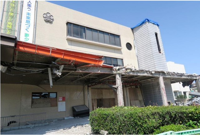
益城町役場東側正面玄関
